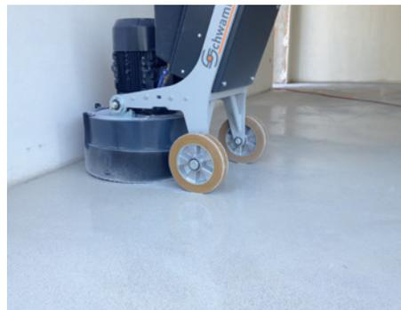
Das Verschleifen dient zum Porenverschluss.
