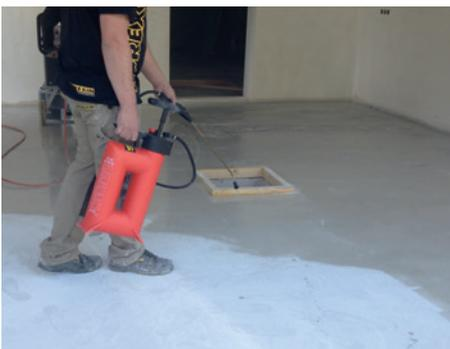
Die Lithium Imprägnierung LI 12 wird mittels Sprüngerät aufgebracht.
