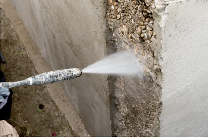
Der Untergrund wird mit einem Hochdruckwasserstrahler vorbehandelt.
