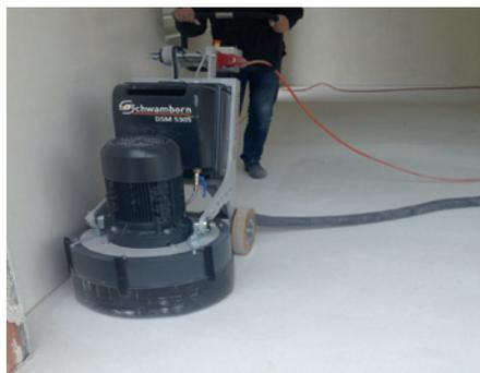
Die Schlämme wird erneut aufgeschliffen.
