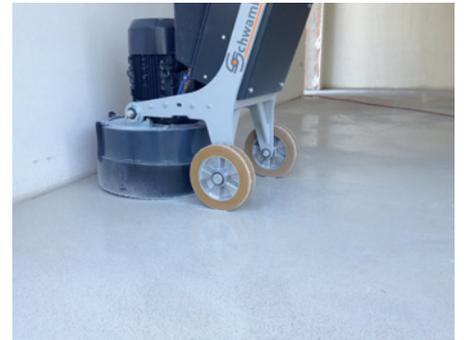
Das Verschleifen dient zum Porenverschluss.
