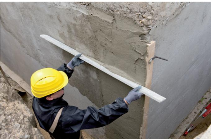
Nach der Beschichtung mit Saniermörtel, wird eine Betonspachtel (Repol BS 05 G, Repol BS 10 W) in der notwendigen Schichtstärke aufgetragen.
