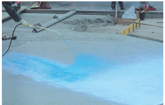
Unmittelbar nach Applikation wird der Verdunstungsschutz aufgetragen bzw. aufgesprüht.
