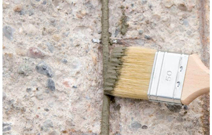
Nach Freilegen und Reinigung der Bewehrung wird der Bewehrungsschutz (Bewehrungsschutz Repol BS 7) aufgetragen.
