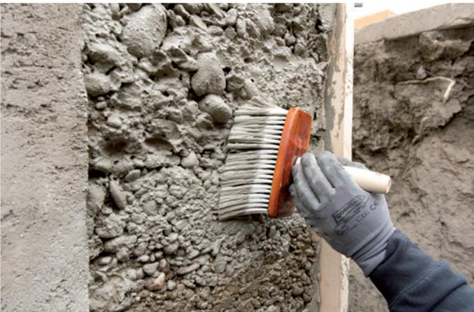
Nach dem Einstreichen der Bewehrung wird das umliegende Mauerwerk sorgfältig vorgenässt und mit der Haftschlämme (Haftschlämme Repol HS 1) eingebürstet.
