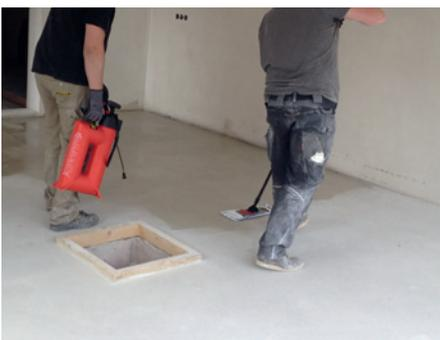
Die Betonimprägnierung TE 18 wird aufgesprüht und mittels Wischmop verteilt.
