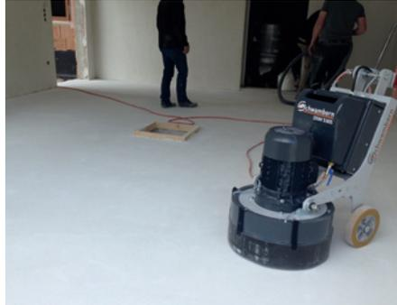
Der Boden wird mit einem Diamantschleifgerät abgeschliffen.
