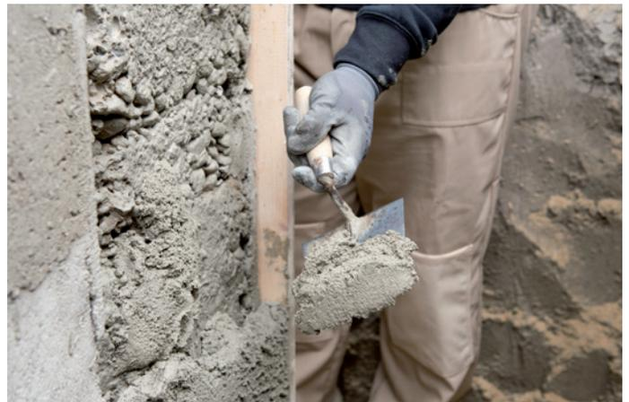
Nach dem Einbürsten der Haftschlämme Repol HS 1 wird nass in nass der Leichtmörtel Repol LM 20 light, Saniermörtel Repol SM 20, Saniermörtel Repol SM 40 in der entsprechenden Schichtdicke aufgetragen.
