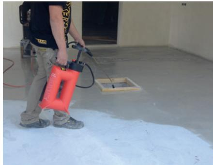
Die Lithium Imprägung LI 12 wird aufgesprüht.
