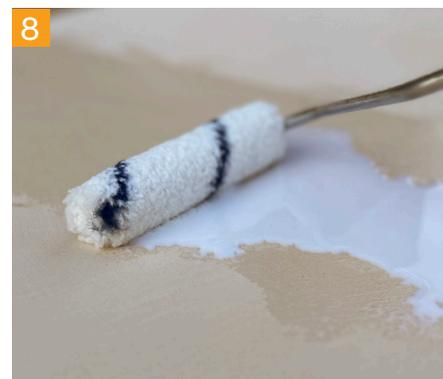
8 Optional: Versiegelung mit Polyurethanversiegelung **PU 40** und rutschhemmendem Füllstoff **RF 8**
