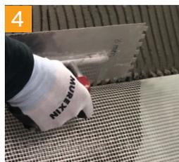
4 Erste Schicht Kleber auftragen und Textilglasgitter einbringen
