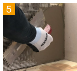
5 Zweite Schicht Kleber auftragen
