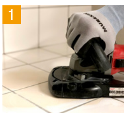
1 Keramik anschleifen
