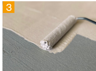
3 Aufbringen der Epoxygrundierung und Absandung
