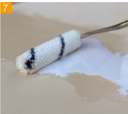
7 Optional: Versiegelung mit Polyurethanversiegelung PU 40 und rutschhemmendem Füllstoff RF 8
