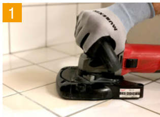
1 Keramik anschleifen
