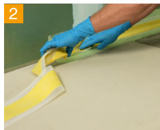
2 Dichtbandeinarbeitung
