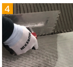
4 Erste Schicht Kleber auftragen und Textilglasgitter einbringen
