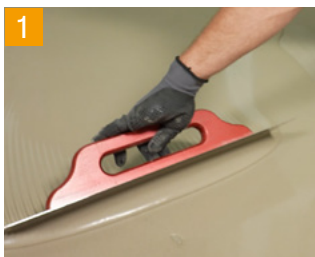
1 Abdichtung mittels Profi Dichtfolie PSM 1K
