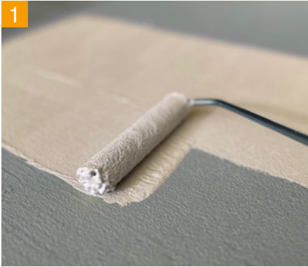
1 Oberfläche grundieren mit Supergrund D4 Rapid
