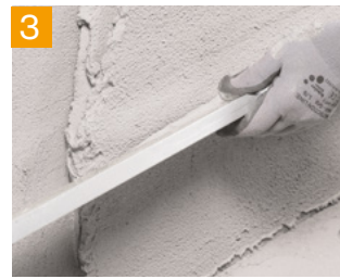
3 Egalisieren mittels Flexklebemörtel Maximo M41
