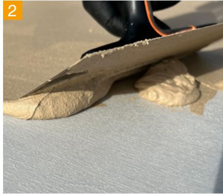
2 Erste Schicht Designcoat AC 1 (verfüllt)
