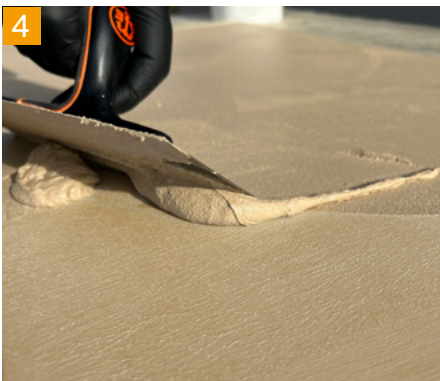
4 Zweite Schicht DesignCoat AC 1
