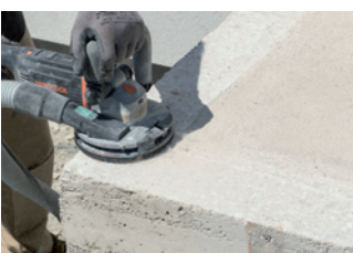
Mittels Handschleifgerät Vertiefung fräsen
