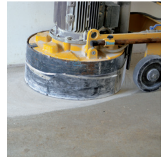
Vorbereiten durch Abschleifen des Untergrundes
