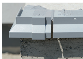
Mittels EP-Kleber Profil versetzen
