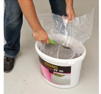
Die Murexin Pflasterfuge **PF 30** befindet sich in einem vor Feuchtigkeit und Luft geschütztem Kunststoffbeutel.
