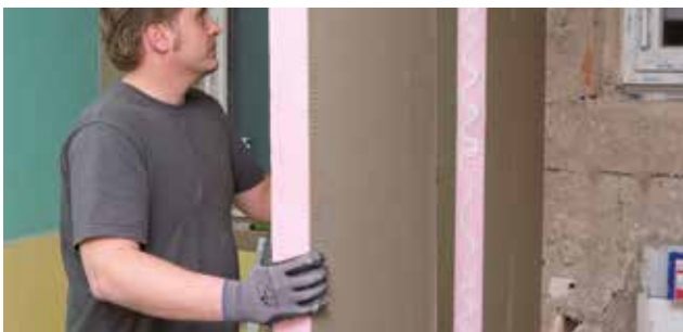
2. Schon kann eine Murexin Uniplatte an die andere gefügt werden.
