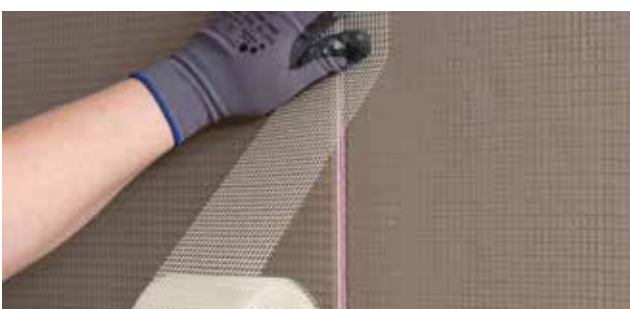
3. Mit Glasseiden-gewebe GS 10 schließen sich Plattenstöße.
