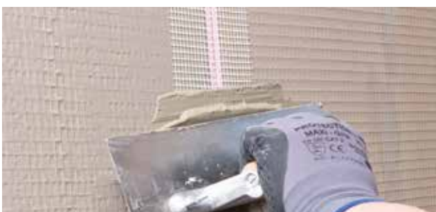
4. Das Glas-seidengewebe GS 10 einlegen, einfach mit Murexin Klebemörtel verspachteln – fertig ist der Untergrund!
