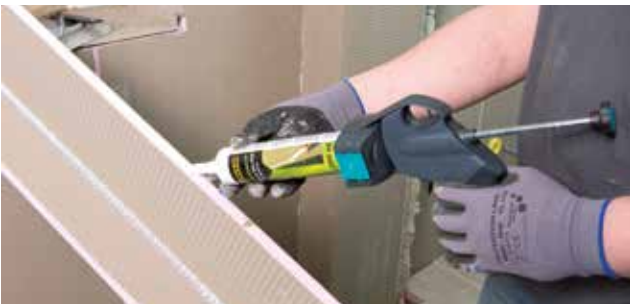
1. Die Kanten der Platte mit Spezialklebstoff X-Bond MS-K88 Express einstreichen.
