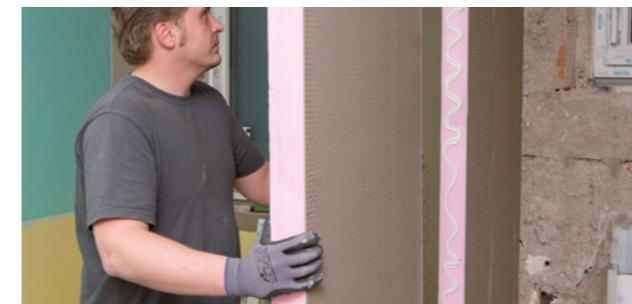
2. Schon kann eine Murexin **Uniplatte** an die andere gefügt werden.
