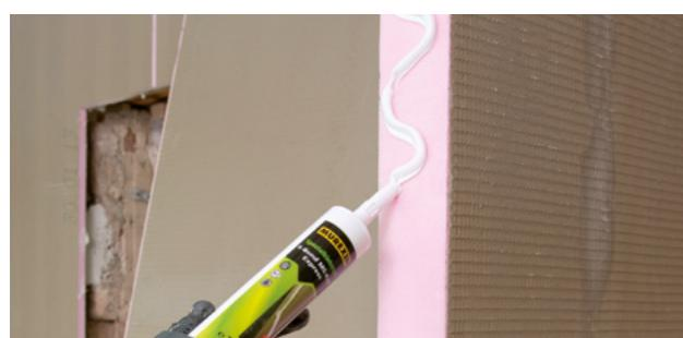
Die Stöße werden mit Murexin Klebemörtel oder Spezialklebstoff X-Bond MS-K88 Express fixiert.
