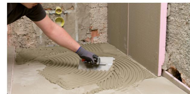
Vollflächige Verklebung mit Murexin Klebemörtel.
