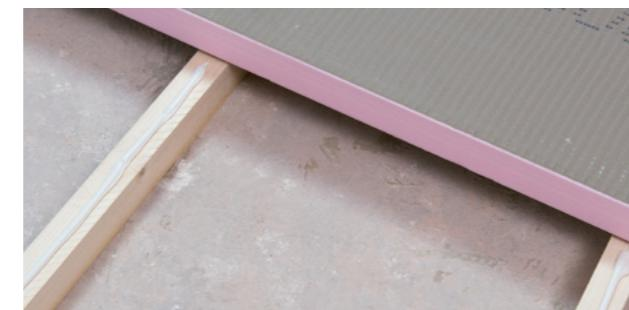
Die Montage der Murexin **Uniplatte** auf Holzrost mittels Verklebung und/oder Verschraubung.
