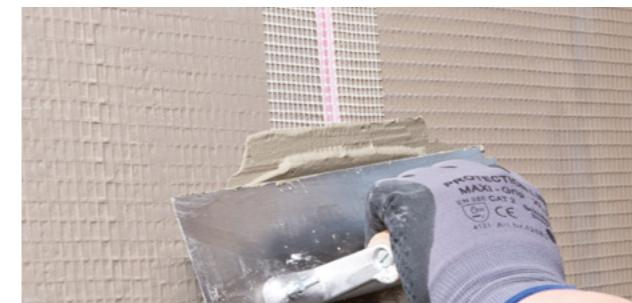
4. Das Glas-seidengewebe **GS 10** einlegen, einfach mit Murexin **Klebemörtel** verspachteln – fertig ist der Untergrund!
