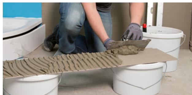
Nach punktuellm oder vollflächigem Aufbringen des Murexin Klebemörtels kann die Murexin Uniplatte direkt auf Boden oder Wand geklebt werden.
