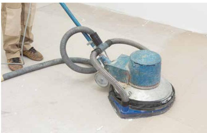
Conformemente alla normativa ÖNORM lo strato di supporto va sottoposto a fresatura, pallinatura o rettifica. B 2236, DIN 18356.
