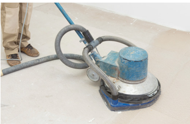
Den Untergrund fräsen, kugelstrahlen oder schleifen nach ÖNORM B 2236, DIN 18356.
