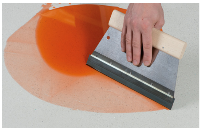
Absperrern mit MUREXIN Silan-Feuchtigkeitssperre MS-X 3 bzw. Silan-Verfestigungsharz MS-X 1
