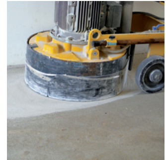
Vorbereiten durch Abschleifen des Untergrundes
