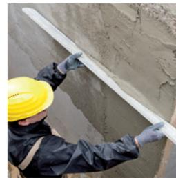
Abziehen des Mörtels mittels Setzlatte.
