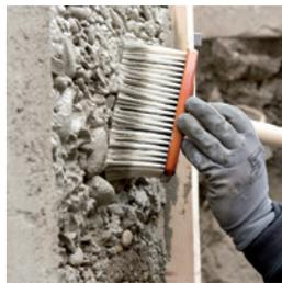
Erstellung eines tragfähigen Untergrundes mittels Haftschlämme **Repol HS 1**
