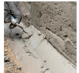
Im Anschlussbereich Fundament/Wand wird ebenfalls mit einem Murexin **Repol** Mörtel eine Hohlkehle ausgebildet.
