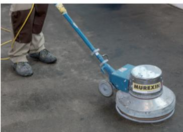
Oberfläche „aufpoliert“ wird und sich dadurch die Haftung der nachfolgenden Beschichtung verschlechtert. Bis zum „Weißbruch“ (weiße, matte Oberfläche) müssen tragfähige, starre 2K-Beschichtungen geschliffen werden.
