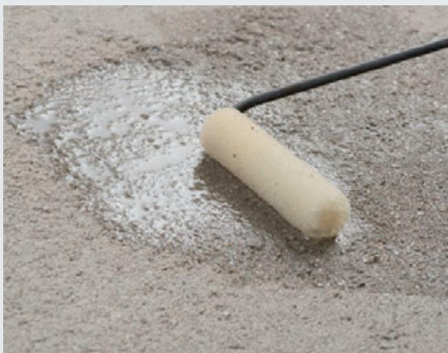
Il grande vantaggio della resina di rinforzo **MS-X 1** è l'essiccazione rapida: essa è già sovralavorabile dopo circa 2 ore e si rivela quindi superiore alle resine di impregnazione bicomponenti a base di EP di molte ore! L'applicazione della resina di rinforzo **MS-X 1** è semplice e sicura in quanto viene fornita monocomponente. La sua formula è a base di silano e per questo **MS-X 1** priva di componenti in grado di migrare e fisiologicamente innocua.
