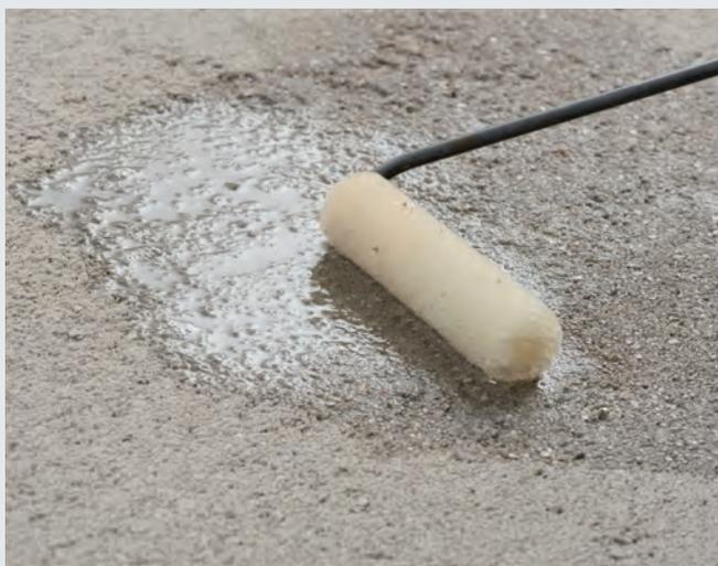
Das große Plus des Verfestigungsharz **MS-X 1** ist die rasche Trocknung: es ist bereits nach rund 2 Stunden überarbeitbar und hängt damit die bisher verwendeten 2-komponentigen Imprägnierharze auf EP-Basis um viele Stunden ab! Das Verfestigungsharz **MS-X 1** ist einfach und sicher in der Anwendung, da es 1-komponentig geliefert wird. Seine Rezeptur ist Silan basierend und daher ist die **MS-X 1** frei von migrationsfähigen Bestandteilen und physiologisch unbedenklich.
