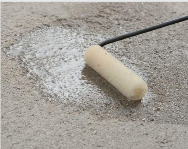
Das große Plus des Verfestigungsharz **MS-X 1** ist die rasche Trocknung: es ist bereits nach rund 2 Stunden überarbeitbar und hängt damit die bisher verwendeten zweikomponentigen Imprägnierharze auf EP-Basis um viele Stunden ab! Das Verfestigungsharz **MS-X 1** ist einfach und sicher in der Anwendung, da es einkomponentig geliefert wird. Seine Rezeptur ist Silan basierend und daher ist die **MS-X 1** frei von migrations-fähigen Bestandteilen und physiologisch unbedenklich.
